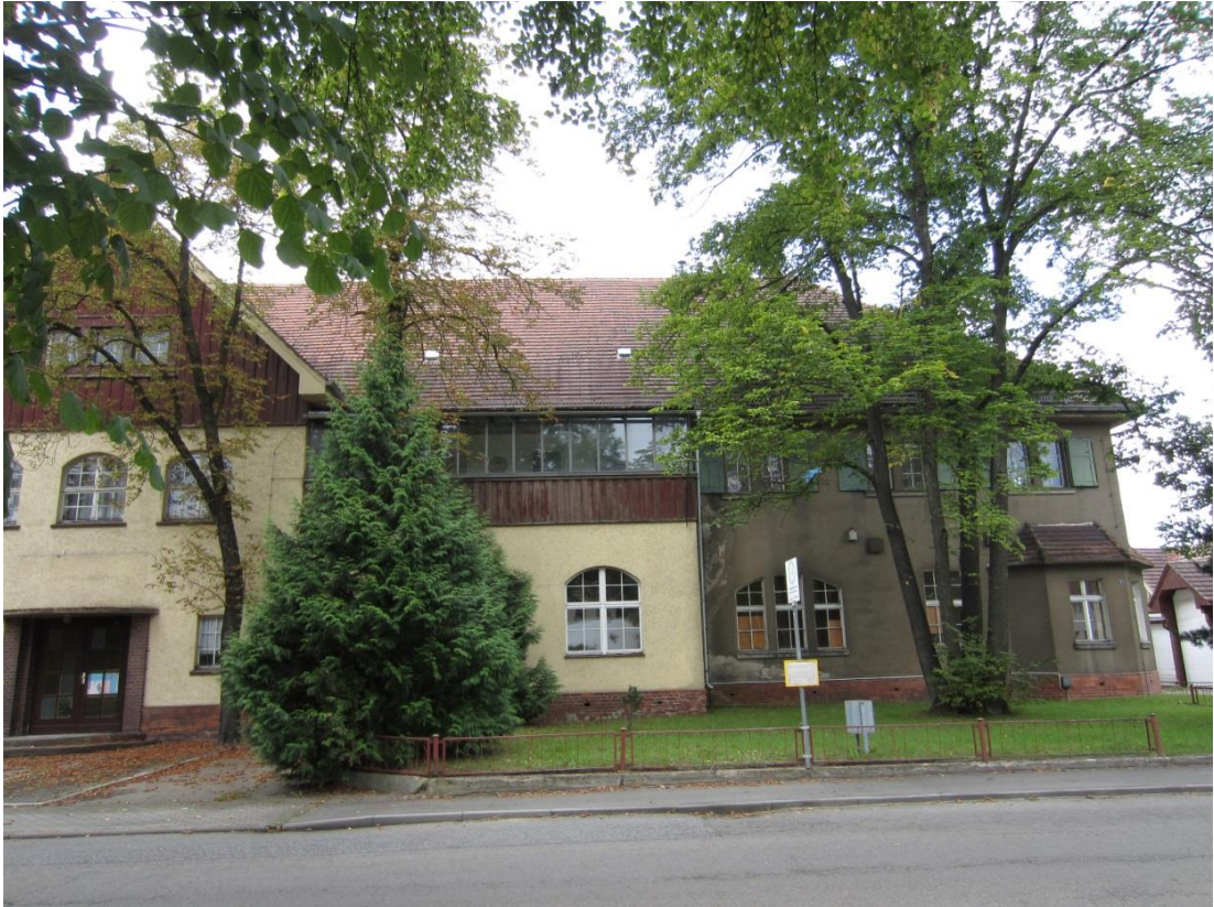
Haupteingang mit Veranstaltungs-, Büro- und Wirtschaftsräumen
