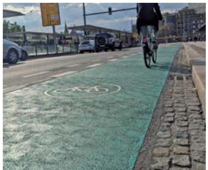
Breit und eben ist die neue Radspur am Leipziger Hauptbahnhof.
