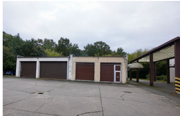
Ansicht der Großgaragen
