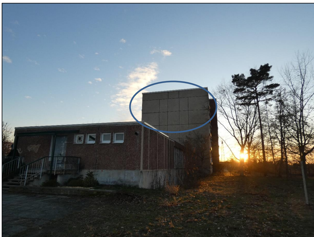
Abbildung 5: Nordostansicht Reihenhaus zur Anbringung der 2 Fledermaus-Fassaden Sommerquartiere
