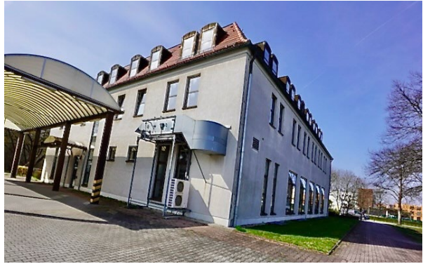
Rückseite des Gebäudes
