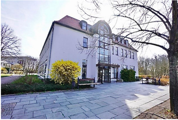
Ansicht Gebäude mit Eingangsbereich und Vorplatz
