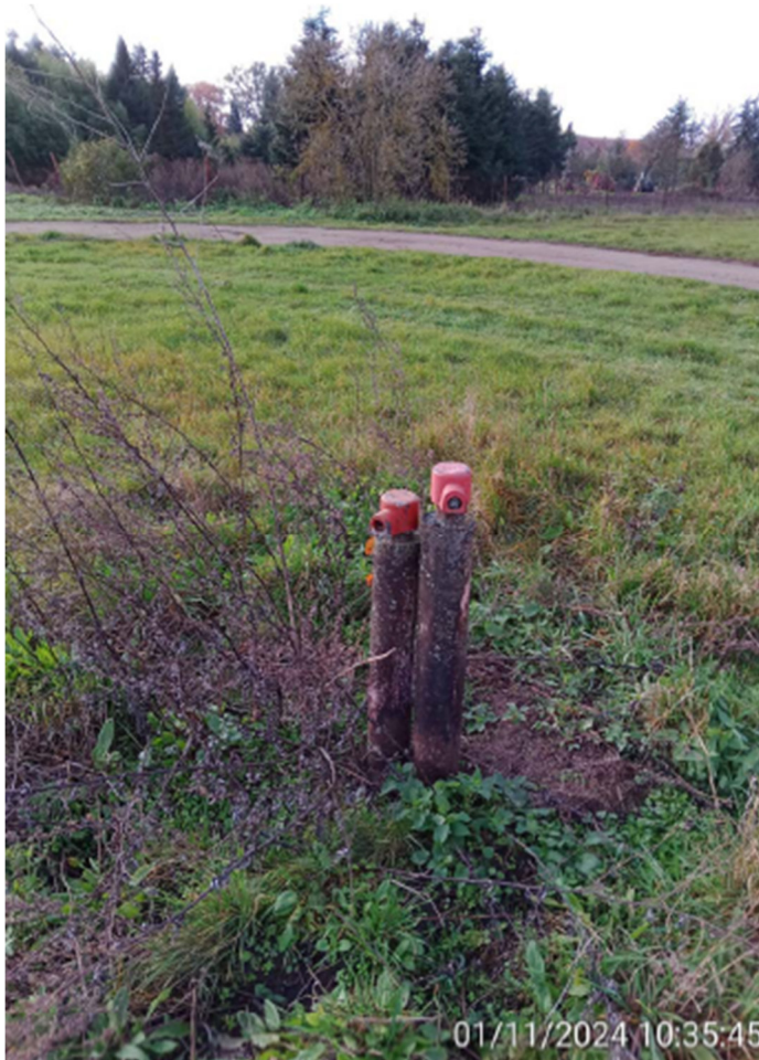
Abbildung G: vorhandene Messstellen (Quelle Stadt Hoyerswerda, Gewässermanagement)
