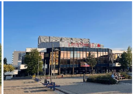
Lausitzhalle Hoyerswerda, Lausitzer Platz
